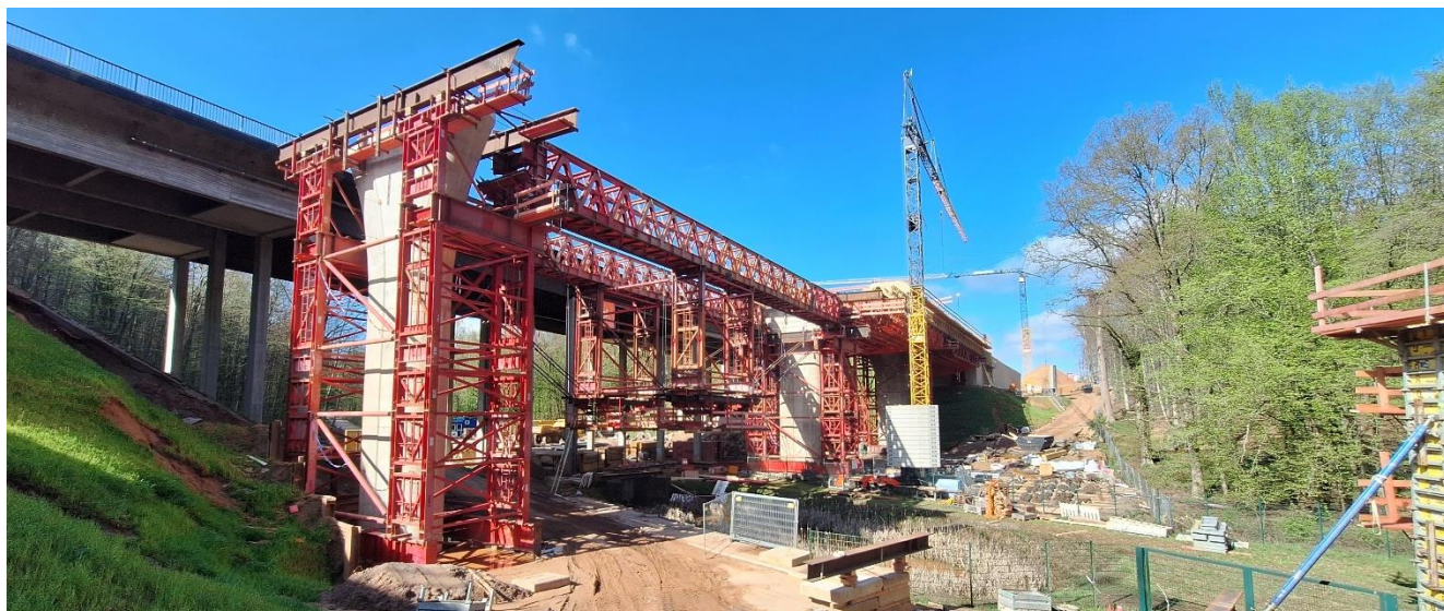
Baustellenfoto von Anfang April 2024
